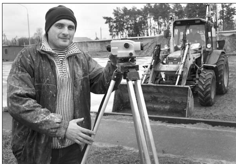
Рабочы Дзяніс Лазоўскі якасьць укладкі пакрыцця кантралюе прыборам
