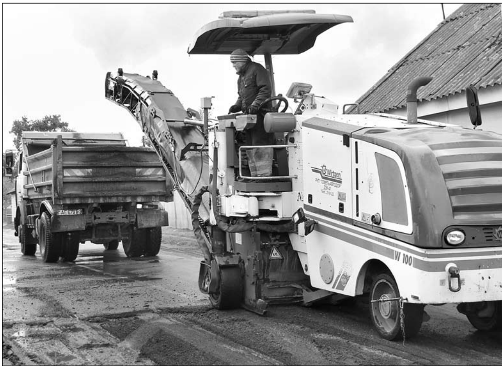
Подготовительные работы на ул. Советской
